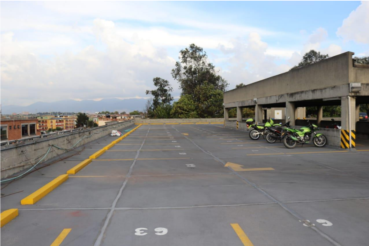
Imagen n°3 , área superior de edificio de parqueaderos CORABASTOS S. A. (vista posterior).
