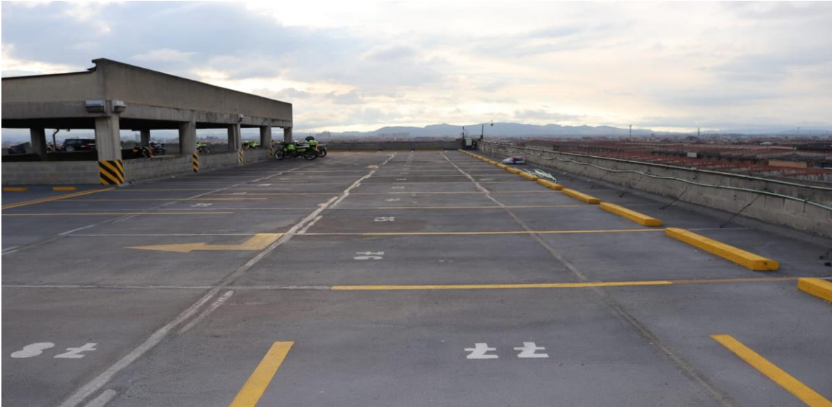
Imagen n°1 , área superior de edificio de parqueaderos CORABASTOS S. A. (vista frontal).
