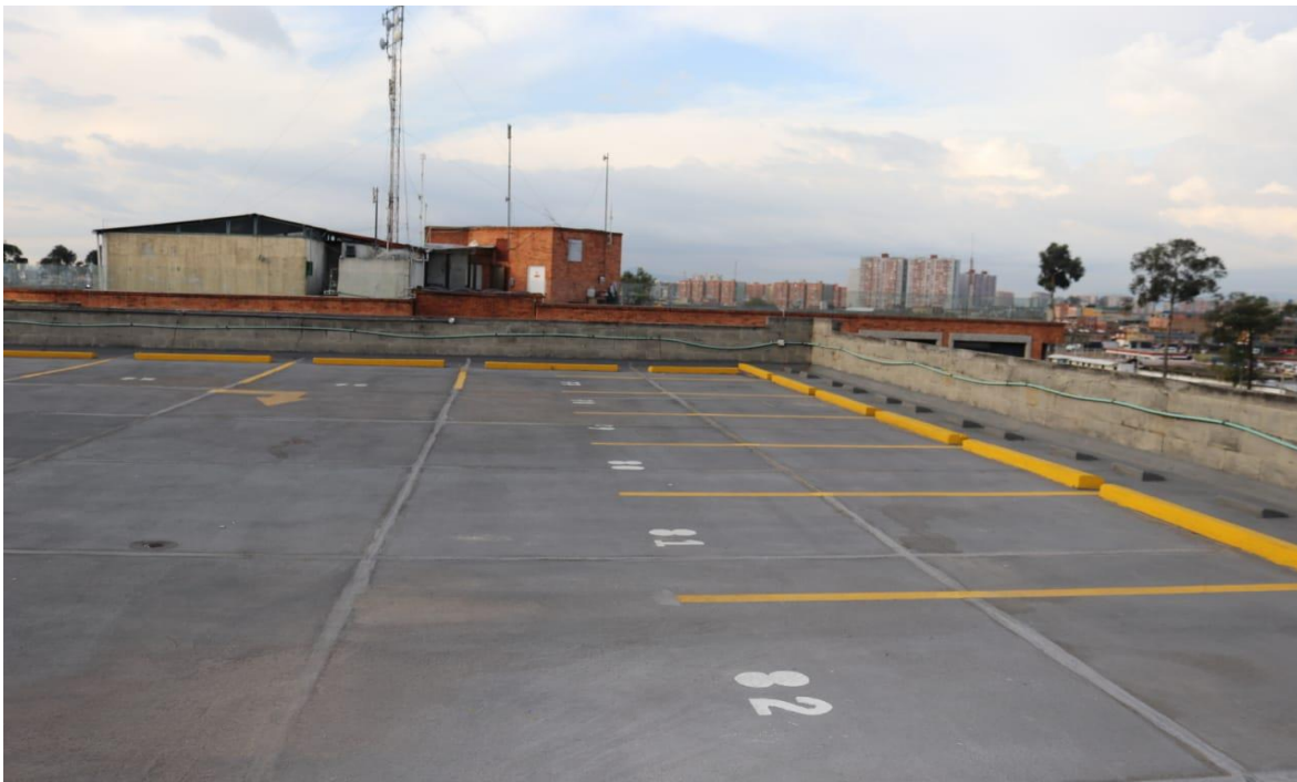
Imagen n°2 , área superior de edificio de parqueaderos CORABASTOS S. A. (vista lateral).
