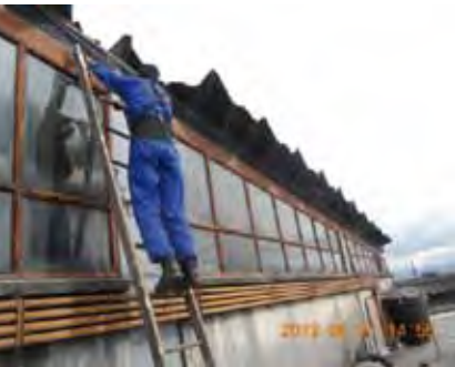
Instalación de Malla (angeo)
