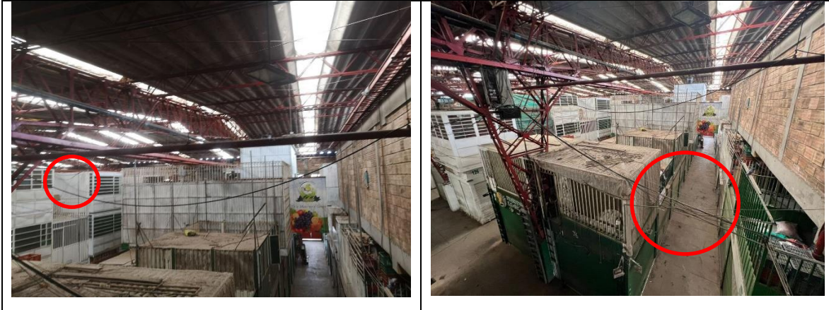
Figura 1. Evidencia fotográfica del estado actual de redes y acometidas internas.
